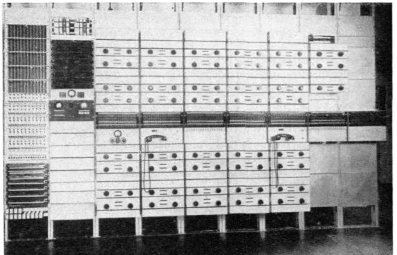
Fig. 4 Enkanalstativ på överdragsstationen i Stockholm
