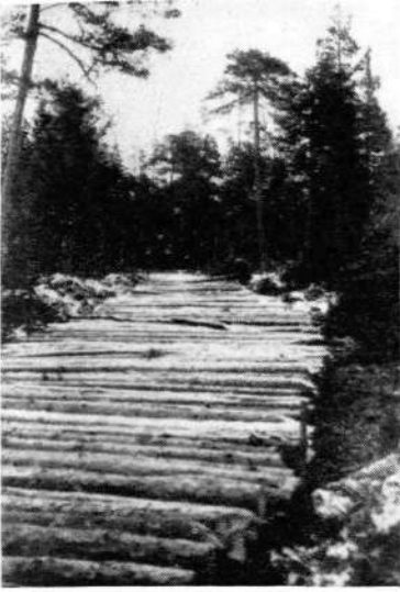
Fig. 3 Vägarbete vid Benhamra
