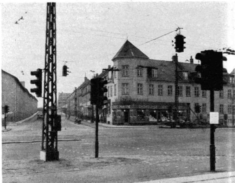
Fig. 6 X 5637 Forskellige Montageformer for Signallanterner
