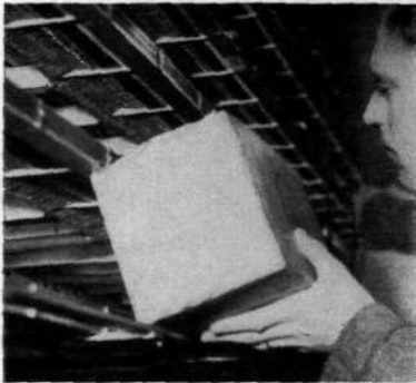
Fig. 4 Nu började genast alla tillgängliga händer rycka ut brytpropparna i den gamla korskopplingen
