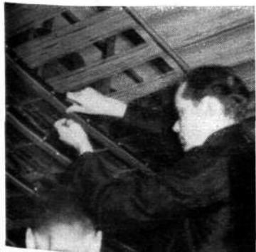
Fig. 6 x 4181 Brytpropparna rammades hem i den nya korskopplingen
