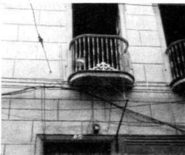
Fig. 6 Abonnentledningar på vägg före ombyggnaden
