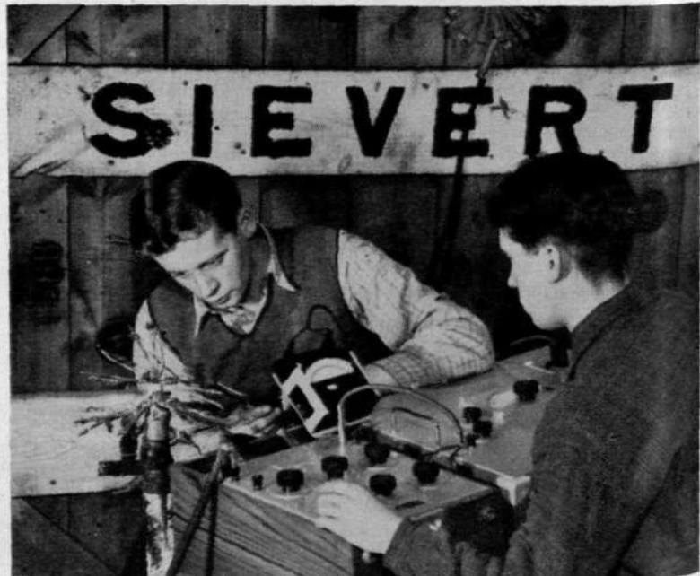
Fig. 17 Karakteristikkätmätning x 5776 den ena kabeländen anslutes intill karakteristikkätmätaren; anslutningen till den andra änden synes i bildens överkant; instrumentet till höger om karakteristikkätmätaren är heterodynindikatorn
