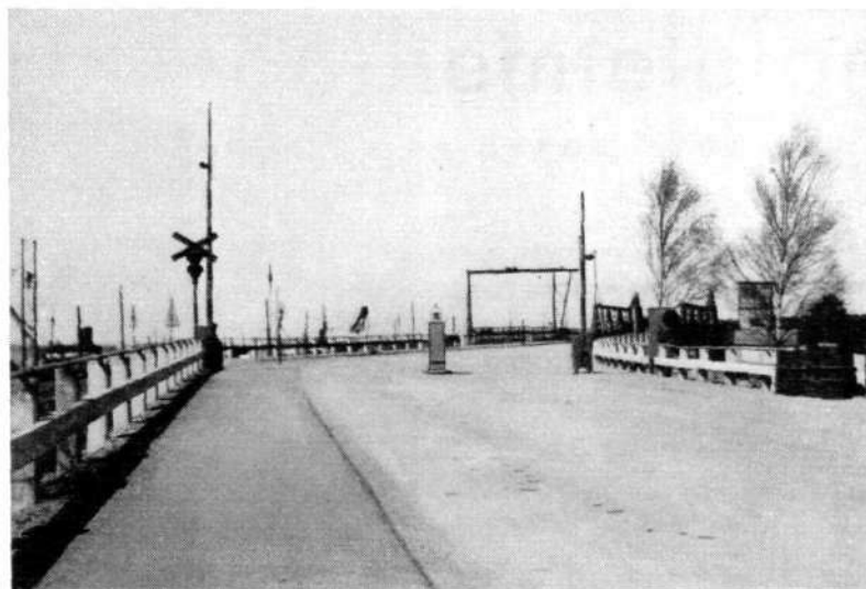
Fig. 2 Fällbommar, ljussignaler och trafikdelare vid infarten till bron
