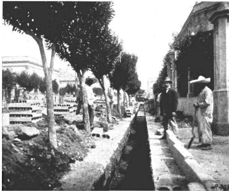
Fig 11. Laying Cement Conduits.
