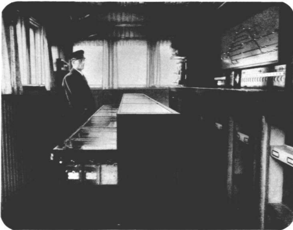
Fig. 20. The Mjølby Interlocking Machine.
